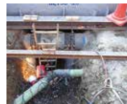
下水道管の耐震化工事
